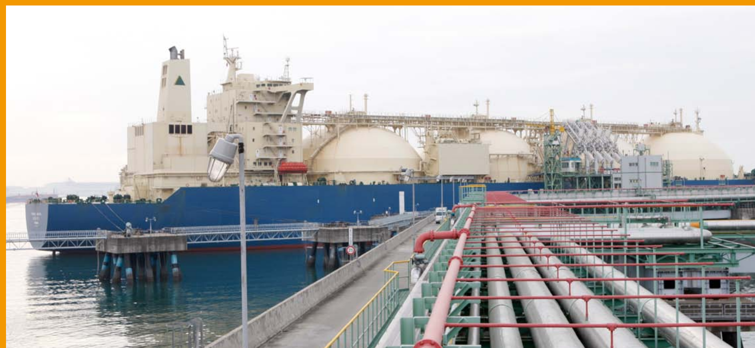
Pyeongtaek LNG ship. Photo Kogas
