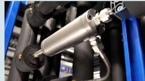
Ejektor für CO<sub>2</sub>-Kältemaschine
